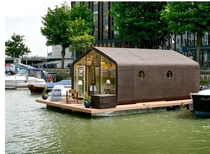
„Modulhaus“ mit Schwimmkörper – HQ100 geeignet - temporärer Leichtbau
