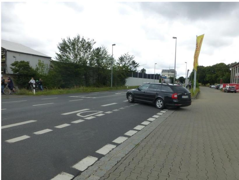
Hier könnte die Sicherheit von Radfahrern im Ein- bzw. Ausfahrtbereich durch eine rote Flächenmarkierung des Radweges und Radsymbolen auf der roten Asphaltfläche erhöht werden.
